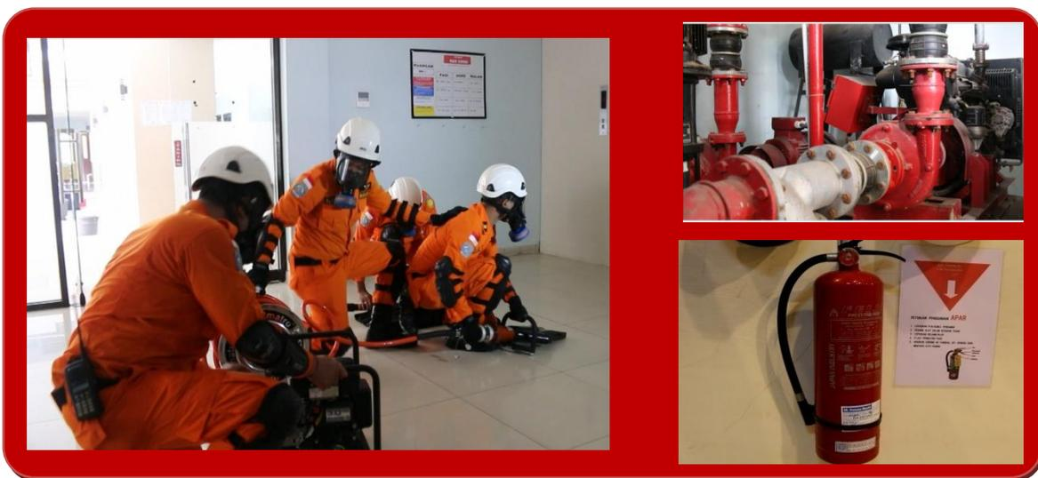
Sistem penanggulangan kebakaran (*fire system*) dilengkapi APAR dan sistem alarm yang terkoneksi dengan *fire hydrant* otomatis.
